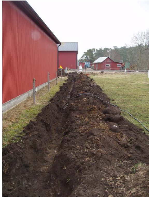
Fig.5. Schaktet genom det område som var i utkanten av 1600-talets gårdsläge.
