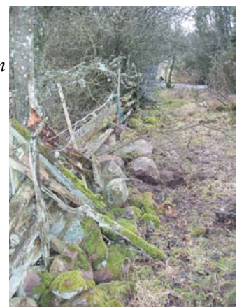
Fig.6 & 7. Till vänster, fig. 6, visar elskåpet och stolpen på gravfältsidan om stenvasten. Den högra bilden, fig.7, visar den återställda vasten. Brottet var där mossa saknas på stenarna.
